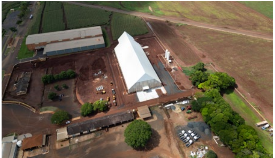
Estrutura de armazenagem de amendoim na Unidade de Grãos III, obra com previsão de finalização em 2026
