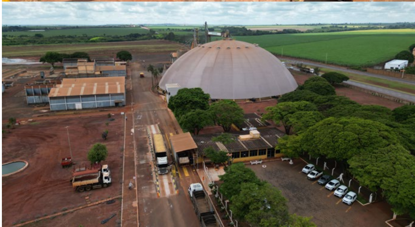
Caldeira para secagem de grãos instalada na Unidade de Grãos I e segunda balança instalada na Unidade de Grãos IV
