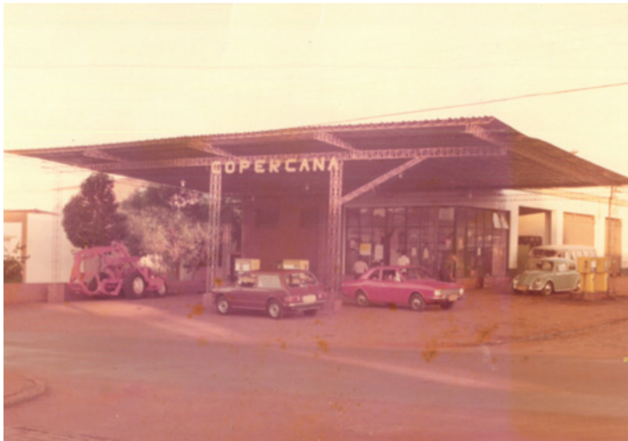
Imagem do primeiro posto em Sertãozinho, detalhe para a primeira bomba com Álcool da história da Copercana
